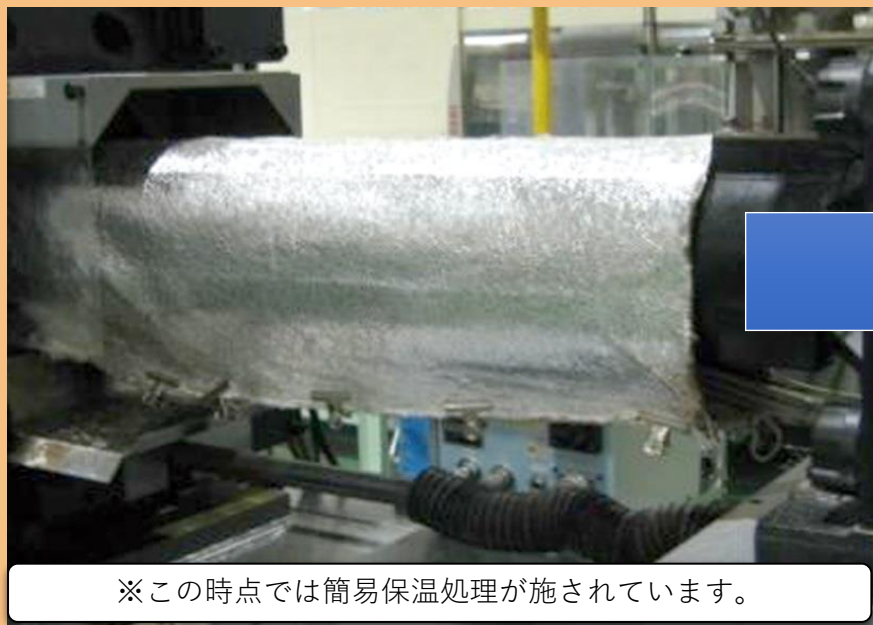
射出成型機（施工前）
