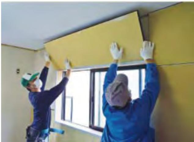
事前に家具の移動などは必要ですが、床や壁を壊さないので粉塵や騒音を極力抑えることができます。現場の寸法に合わせたパネルを既存の壁や床に取付け、その上から仕上げでお好きな壁紙を張ることができます。家にいながらいつの間にか工事が完了しているのもココエコならではの魅力です♪
